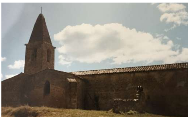
L'ancien cimetière contre l'église avant les travaux
