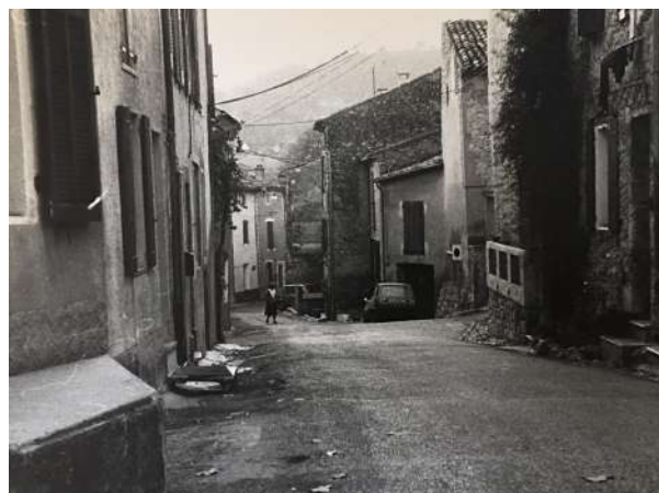
La grand rue avant l'enfouissement des lignes électriques et téléphoniques
