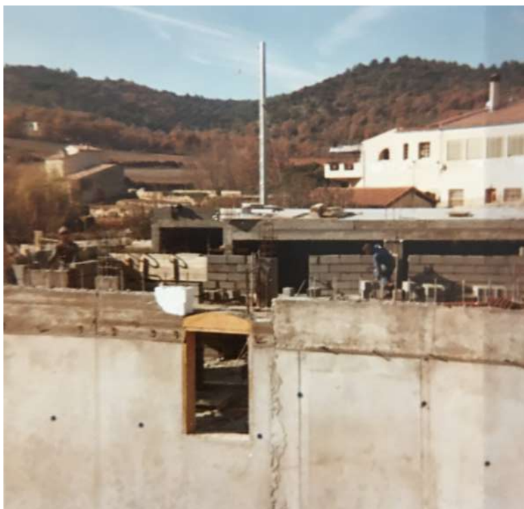
1983 : construction du bâtiment municipal
