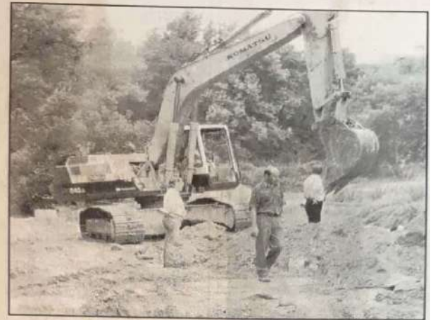
La future station sort de terre (Ph CD).
