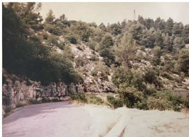
L'ancienne RD 952 juste avant les travaux
