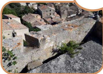
Travaux à la tour
