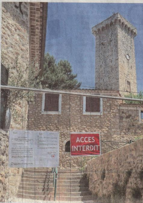
Il faudra deux années de travaux pour remettre sur pied la Tour de l'Horloge. /PHOTO G.G.
