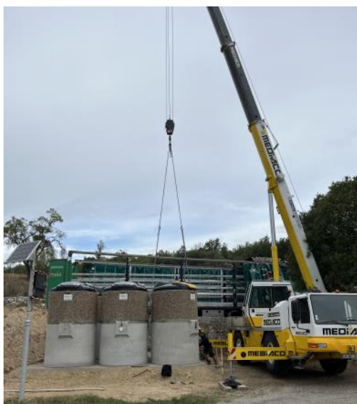
Pose des containers
