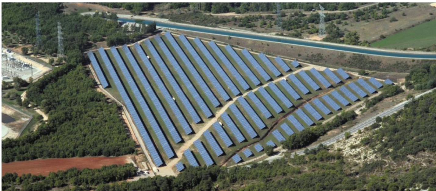
Centrale solaire de Vinon-sur-Verdon
