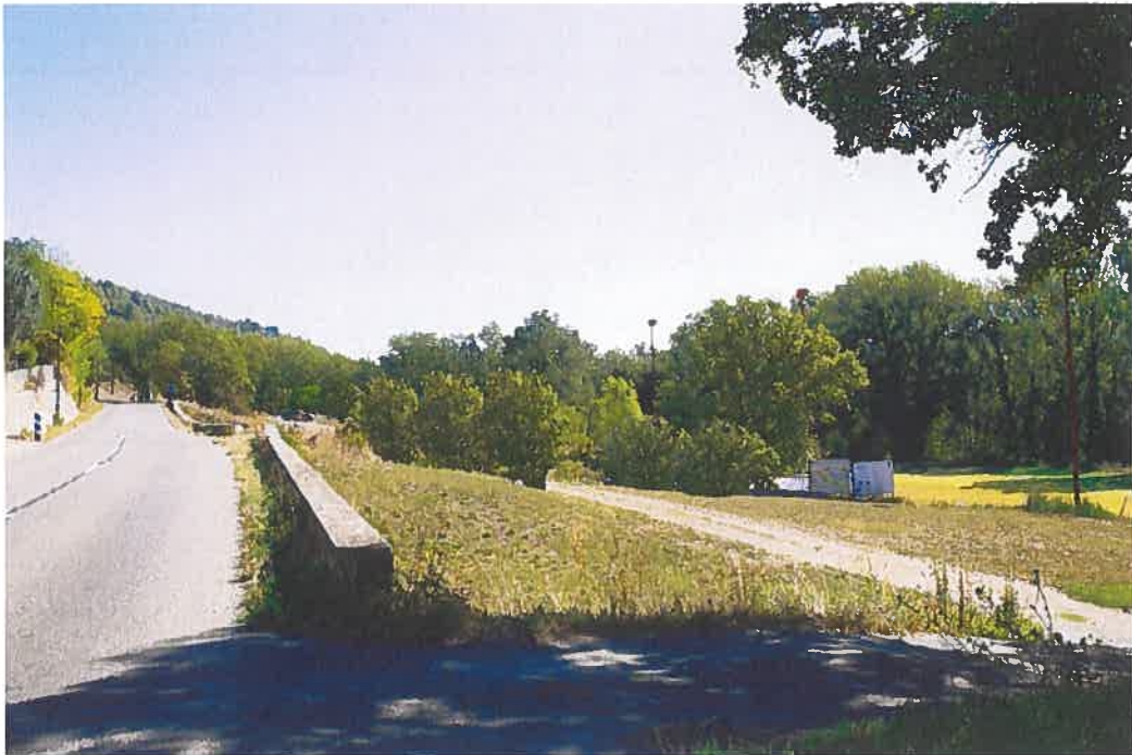
Insertion paysagère avec végétation projetée, vue est, vers Allemagne
